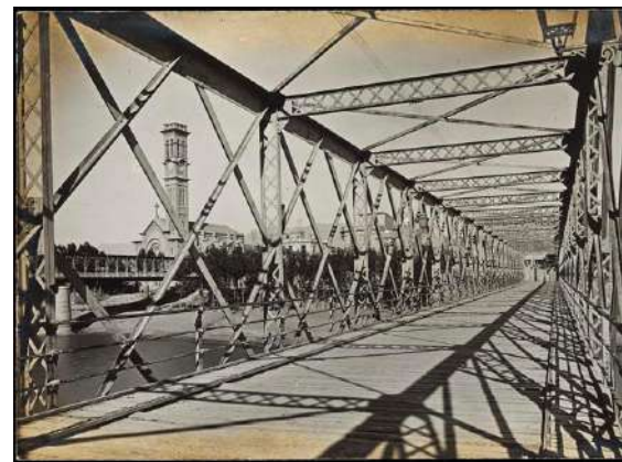
Pont del Cinta
